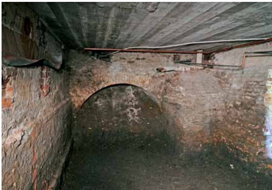
De fundering van de Oeterwalmolen onder het Flevogemaal
